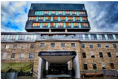
Norras Bodø paigaldati Nordlandi haigla renoveerimise käigus 530 GEZE automaatkõrgsüsteemi.
